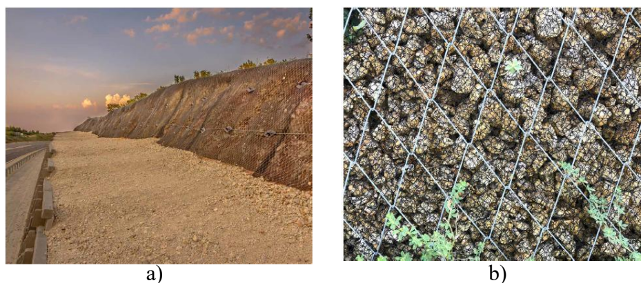
Figura 4. a) Situazione costruzione pendio rinforzato (2015); b) Esumazione del campione in sito dopo cinque anni (2020).
